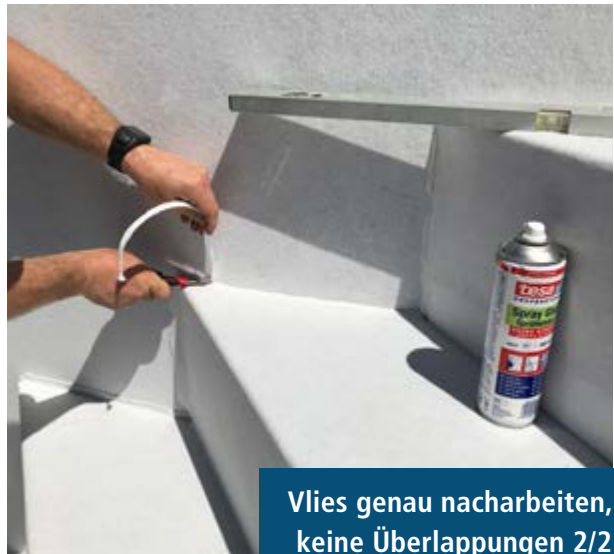
Vlies genau nacharbeiten, keine Überlappungen 1/2
