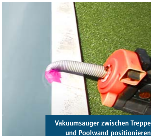
Ein Vakuumsauger kann das Verlegen deutlich erleichtern
