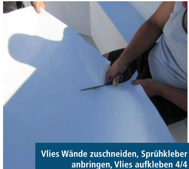
Vlies Wände zuschneiden, Sprühkleber anbringen, Vlies aufkleben 2/4
