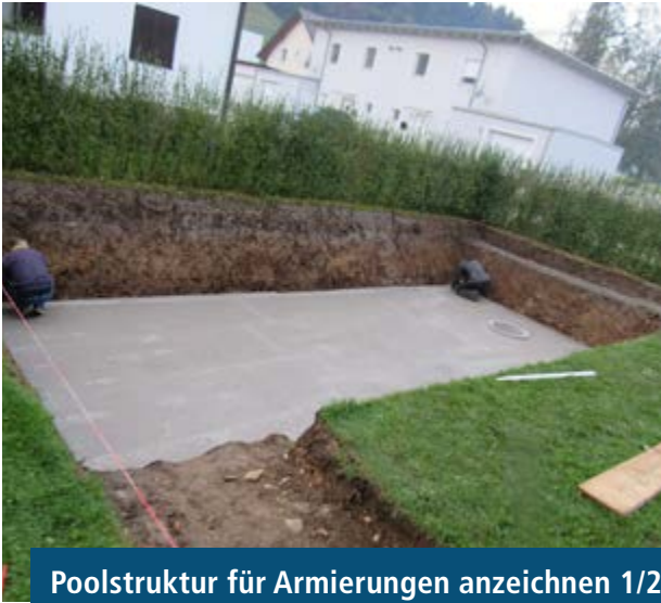
Poolstruktur für Armierungen anzeichnen 1/2
