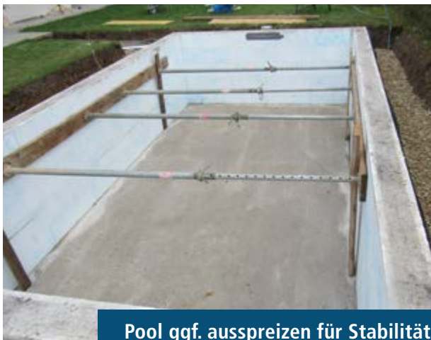
Schotter Hinterfüllung
