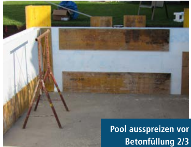
Pool ausspreizen vor Betonfüllung 1/3
