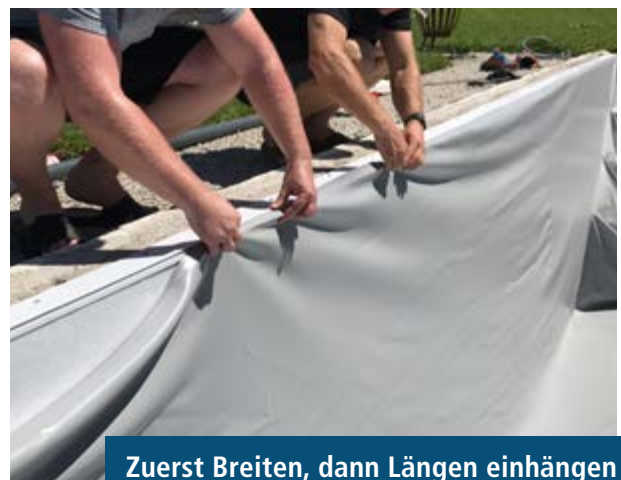
In Ecke mit Treppe beginnen und anschließend weitere Ecken einhängen
