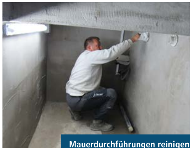
Fittings reinigen vor Ankleben an Mauerdurchführungen
