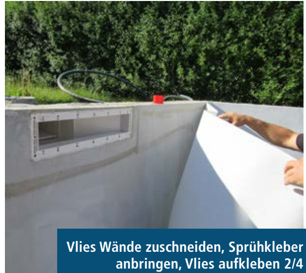
Vlies Wände zuschneiden, Sprühkleber anbringen, Vlies aufkleben 1/4
