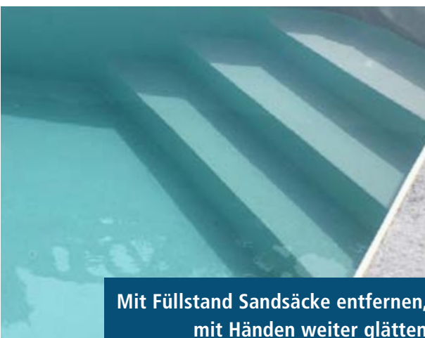
Nach Einrichten der Treppenfolie ausreichend beschweren
