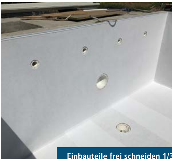
Vlies Wände zuschneiden, Sprühkleber anbringen, Vlies aufkleben 3/4
