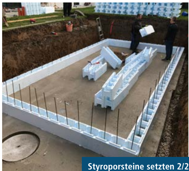
Senkrechte Eisenstäbe einsetzen 2/2
