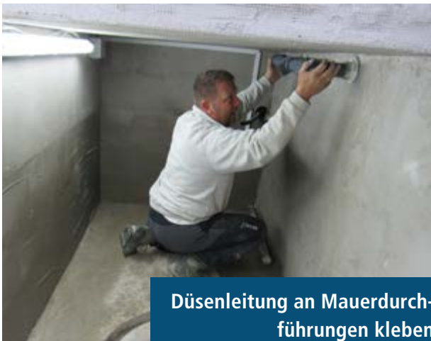
Fittings reinigen vor Ankleben an Mauerdurchführungen
