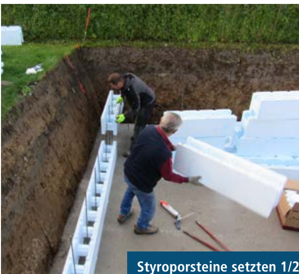
Senkrechte Eisenstäbe einsetzen 1/2
