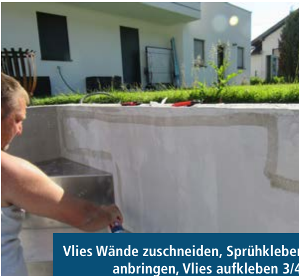
Vlies Wände zuschneiden, Sprühkleber anbringen, Vlies aufkleben 1/4
