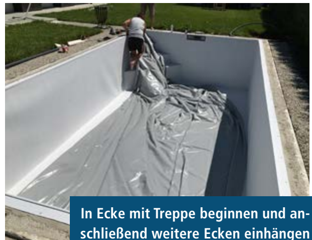
Folie ausbreiten, Stufenausbildung berücksichtigen, Folie erwärmen lassen
