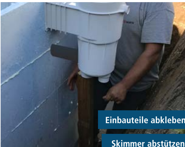
Skimmer ohne Flansch etwas vor die Wand setzen, sodass er später, wenn vernetzt und verspachtelt, bündig abschließt
