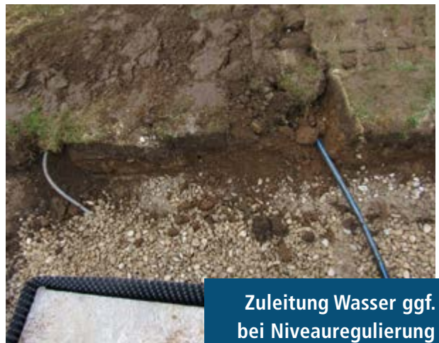
Schotter Hinterfüllung
