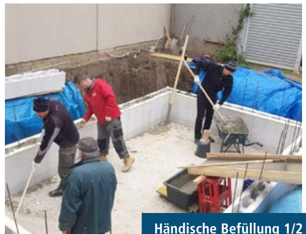
Styroporsteine langsam mit Beton befüllen 1/2
