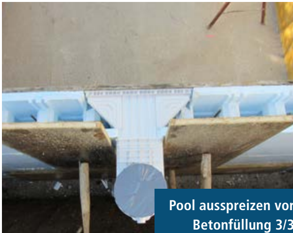
Pool ausspreizen vor Betonfüllung 1/3
