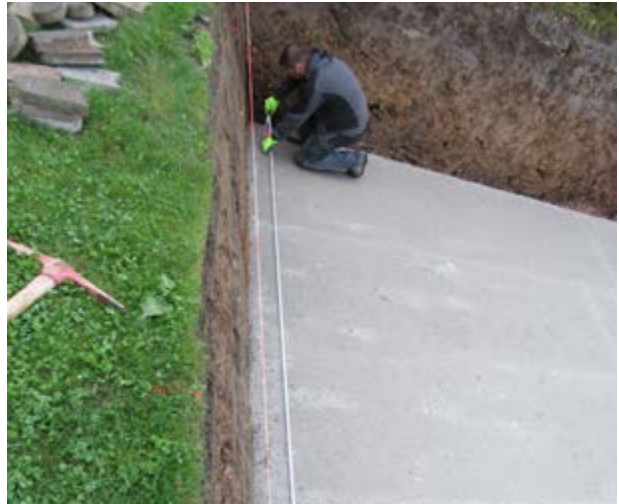
Poolstruktur für Armierungen anzeichnen 1/2
